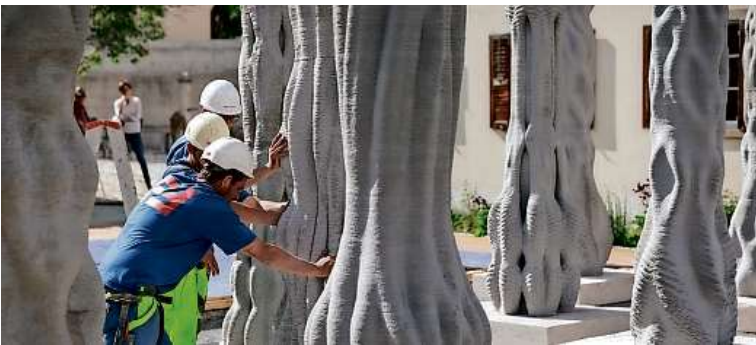
Bauen der Zukunft: Die im digitalen Druckverfahren hergestellten Betonsäulen werden von ETH-Mitarbeitern in Riom aufgestellt.
